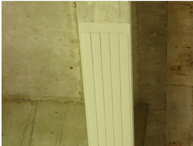
Exemple de poutre renforcée
