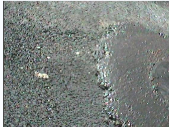
relief trop important sur le renformis béton bitumineux
