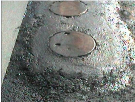
relief trop important sur le renformis béton bitumineux
